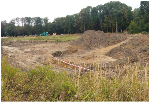
Im Rahmen des LIFE+ Projekts »Elbauen bei Vockerode« wurde der Autobahndamm an der A9 als neue Hochwasserschutzanlage ertüchtigt (Foto: LHW).
