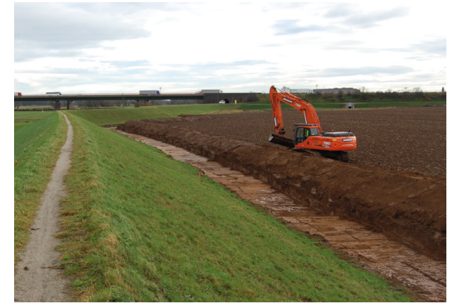
Archäologische Dokumentationen (hier: maschineller Oberbodenabtrag) im Bereich des Gätzer Bergdeichs. Im Hintergrund ist die A9 erkennbar.
