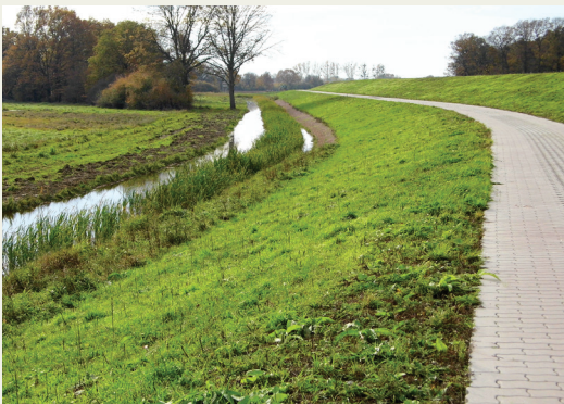
Der erste Deichabschnitt nahe Obselau wurde bereits 2012 fertiggestellt.
