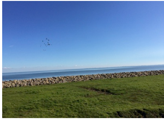
Abbildung 3: Sommerdeich auf Langeneß mit vorgelagertem Deckwerk
