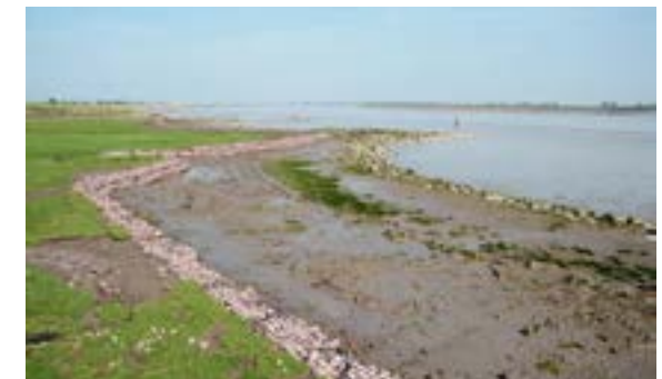
Sanfter Schutz mit Steinwalzen: Bei Coldeborg bekommt der Fluss wieder mehr Gestaltungsspielraum
